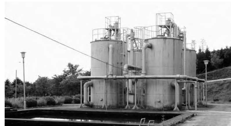
双葉地方水道企業団小滝平浄水場
