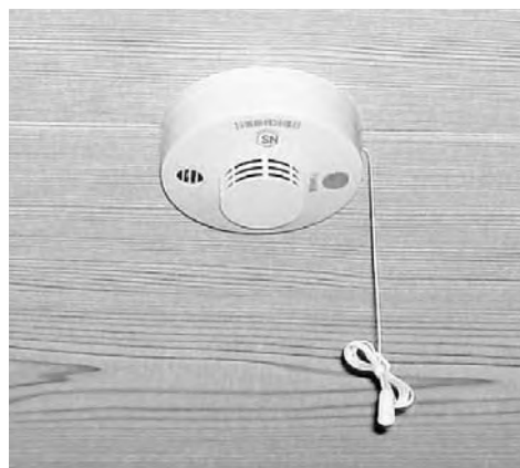
一般家庭用「火災報知器」
