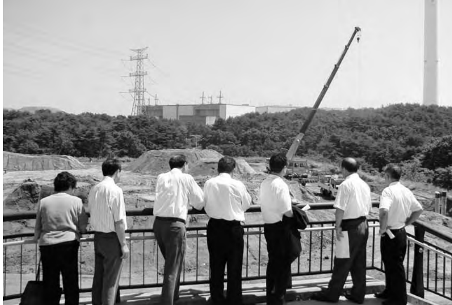
サッカー雨天練習場新築工事現場を視察
