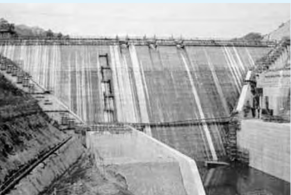
楢葉町に建設中の木戸ダム
