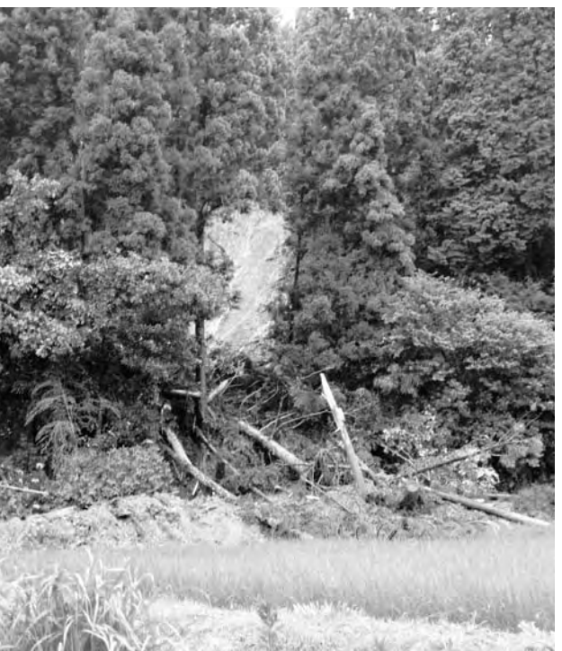
台風4号による崩落現場（上北迫曲田地区）
