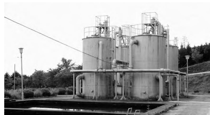
双葉地方水道企業団小滝平浄水場
