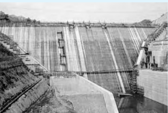
楢葉町に建設中の木戸ダム
