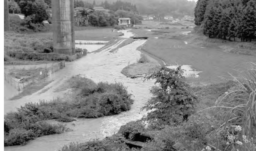
2級河川広野川の氾濫状況（折木大田川地区）
