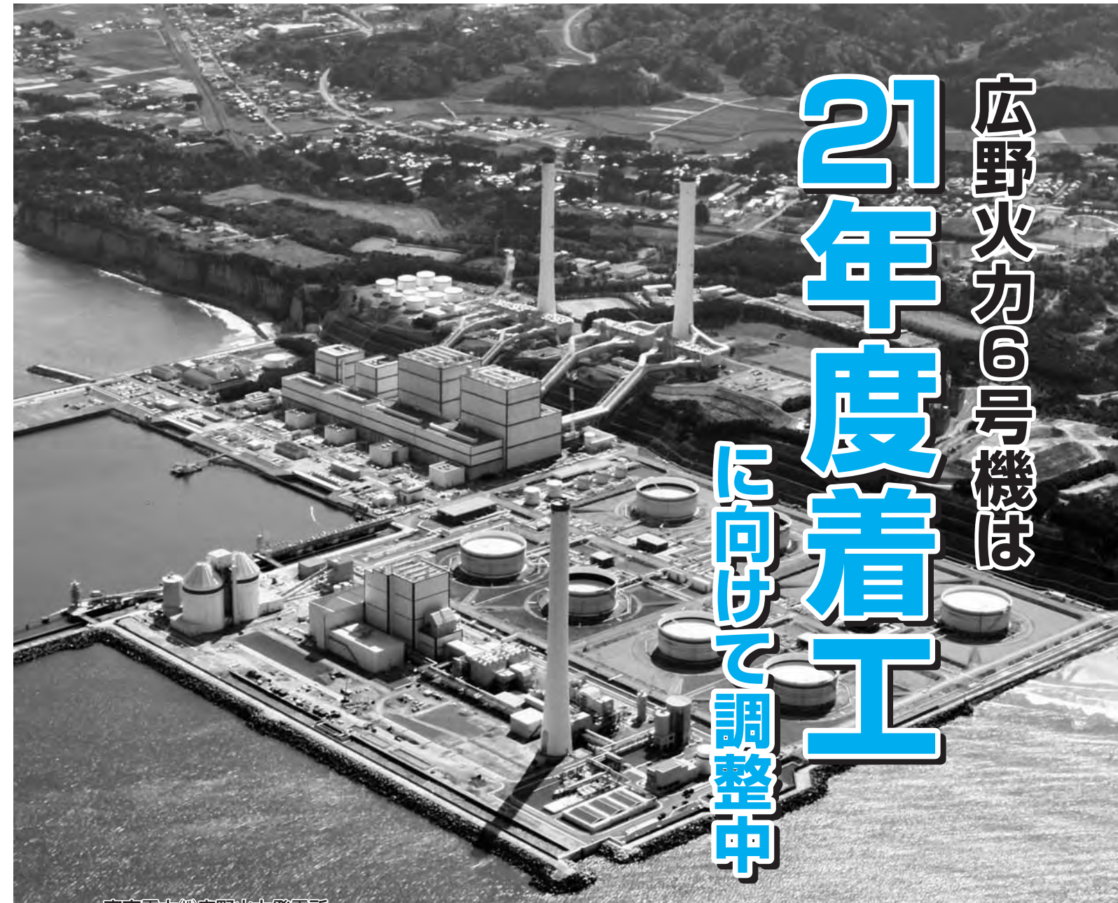
東京電力(株)広野火力発電所
