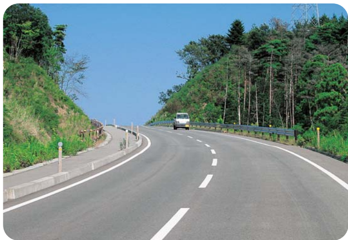
5号機にかかる交付金で整備した中央台・山ノ神線
