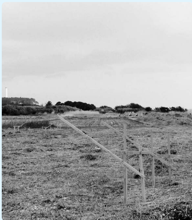
工事が始まった県道「広野・小高線」(下浅見川地区)
