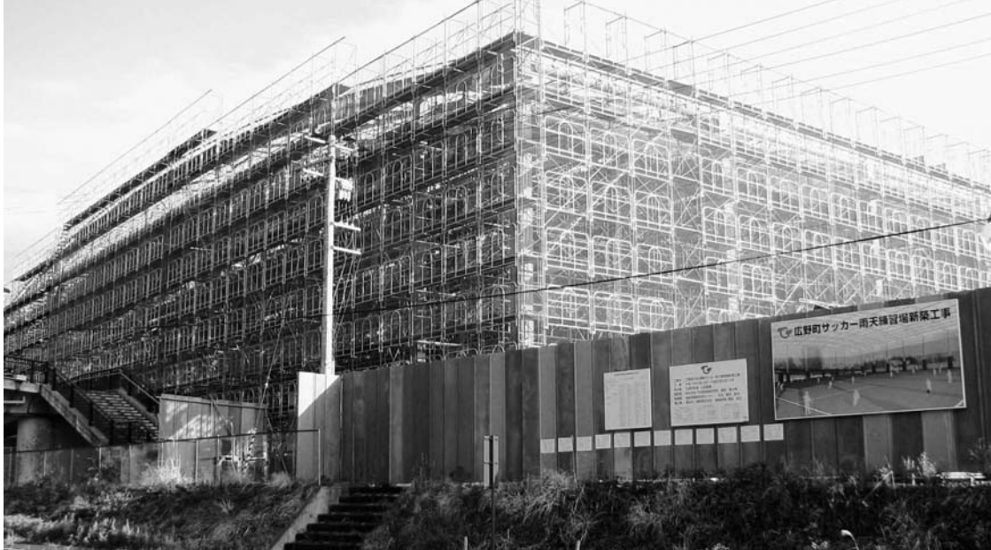
工事が進む広野町サッカー雨天練習場
