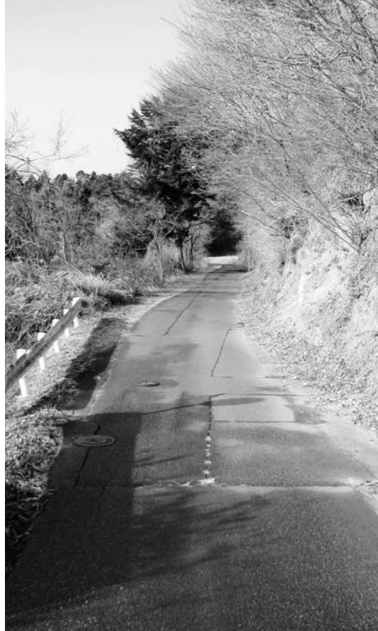
改良整備予定の町道「苗代替線」
