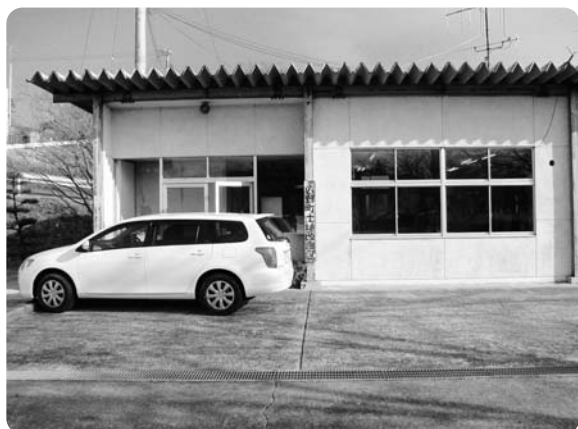
広野町土地改良区(苗代替地区)
