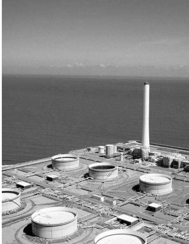
交付金の対象となった広野火力の石油備蓄タンク
