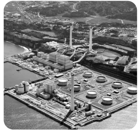
東京電力㈱広野火力発電所
