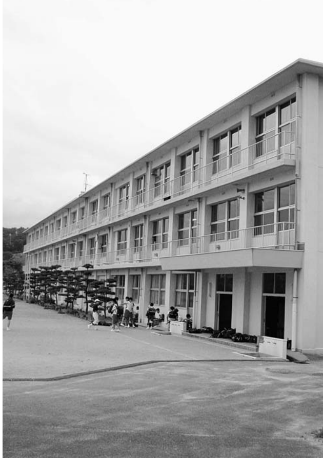
耐震補強工事が施されている中学校
