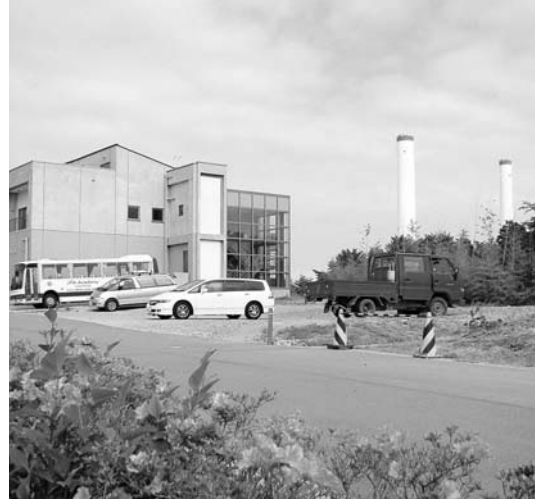
サッカー支援センター増築工事予定地
