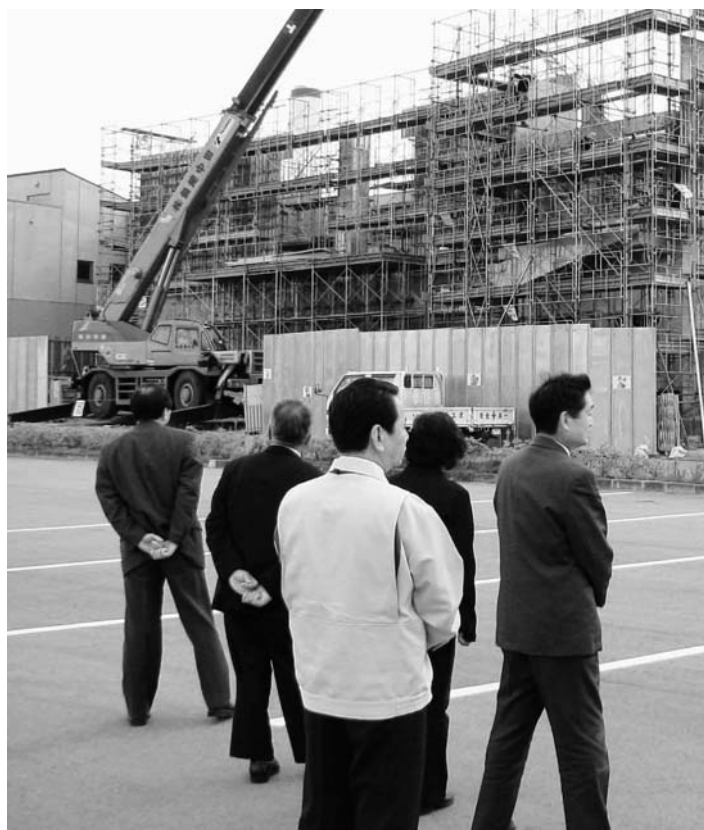
広野町サッカー支援センター増築工事を調査
