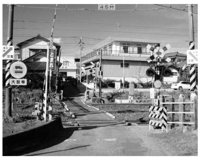
拡幅工事が計画されている鍛冶屋前踏切（下浅見川地区）
