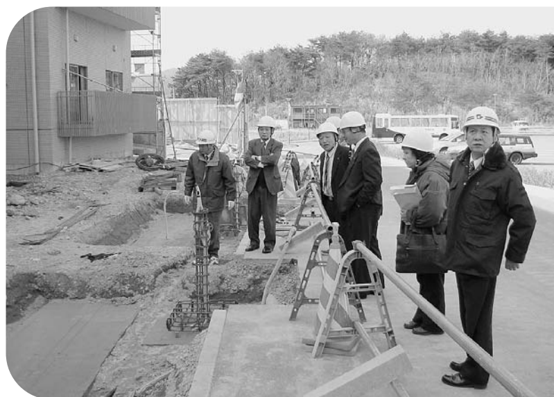
男子寄宿舍増築工事現場を視察
