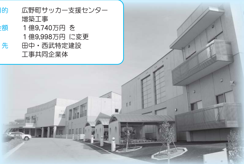
「広野町サッカー支援センター」完成
