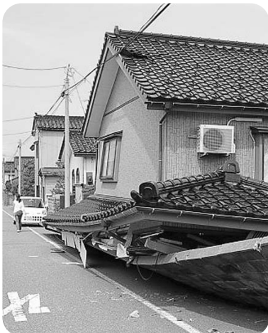
地震被害にあった木造住宅 (写真提供：首都大学東京 土質研究室)
