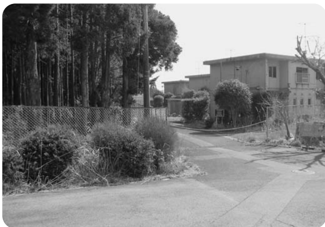
特別養護老人ホーム建設予定地
