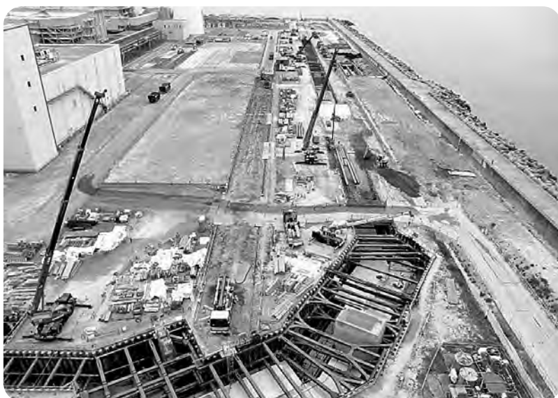
建設が進む東京電力(株)広野火力発電所6号機
