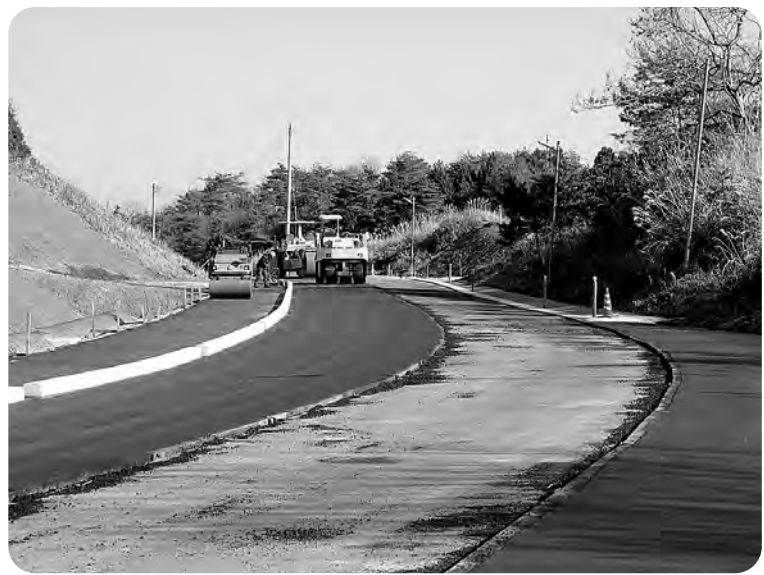
舗装が施される町道苗代替線
