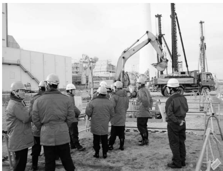
広野火力6号機建設現場視察
