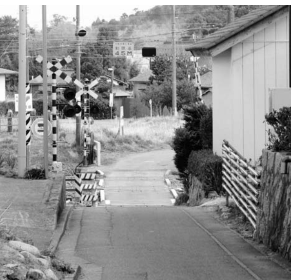
拡幅改良予定の踏切（広長地区）
