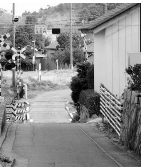
拡幅改良予定の踏切（広長地区）
