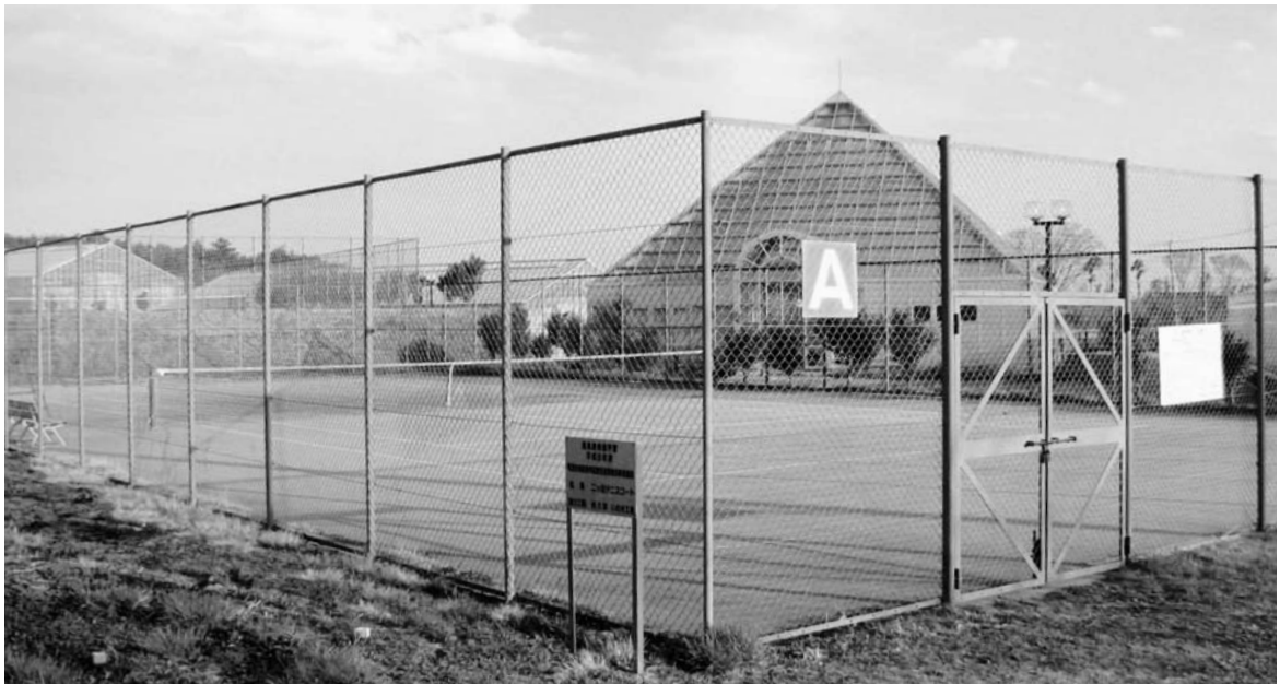
改修されるテニスコート
