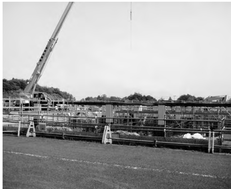
増設工事に着手した企業（広野工業団地）
