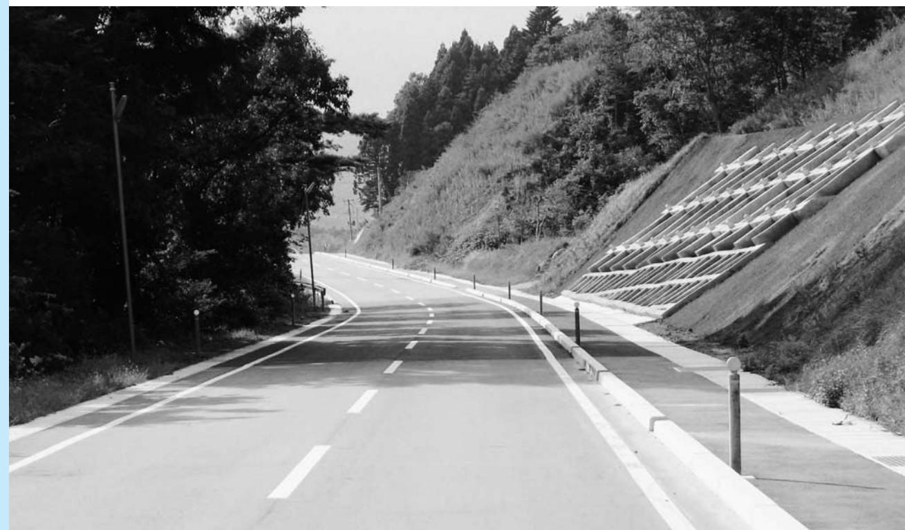
▲舗装改良された町道苗代替線
