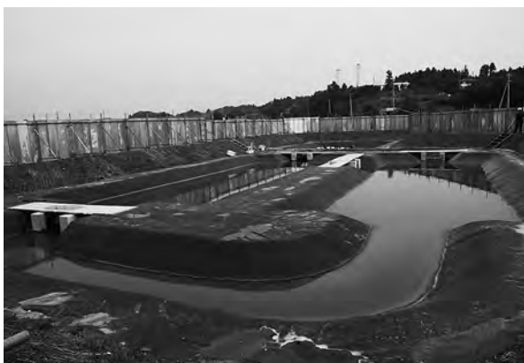
▲工事が完成した仮設の下水処理場
