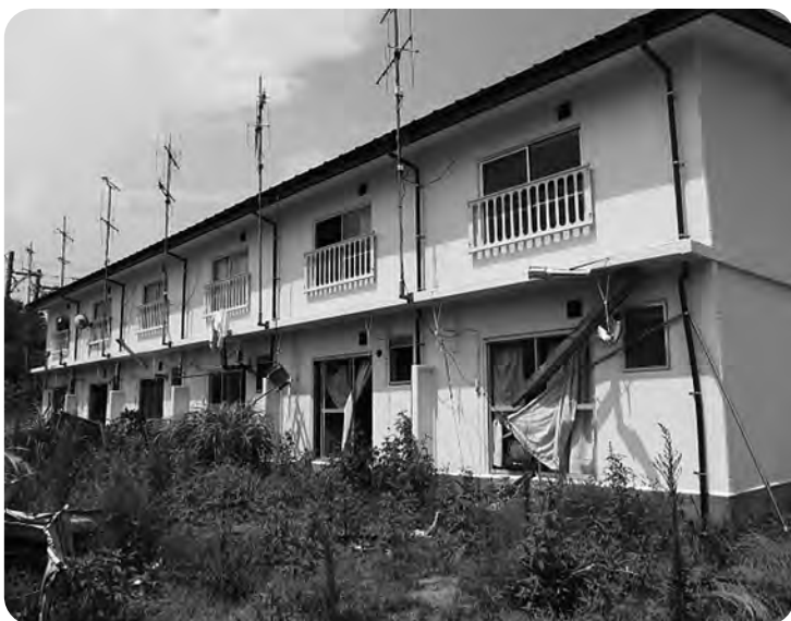
▲津波被害を受けた浜田住宅
