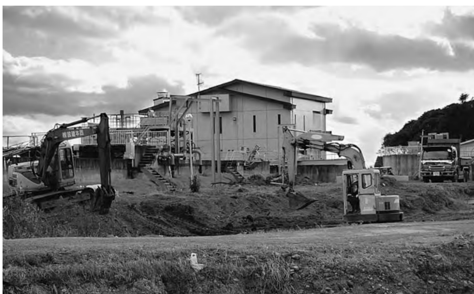
▲復旧が進む下水処理場
