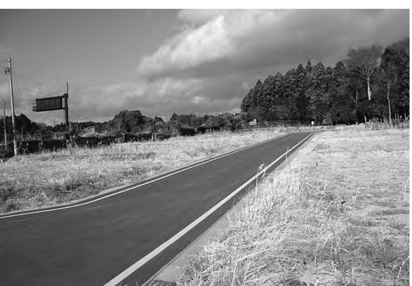
▲早期分譲が求められる宅地造成地（大吹地区）
