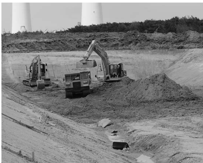
工期が延長された仮置き場整備工事（下北迫・東町）
