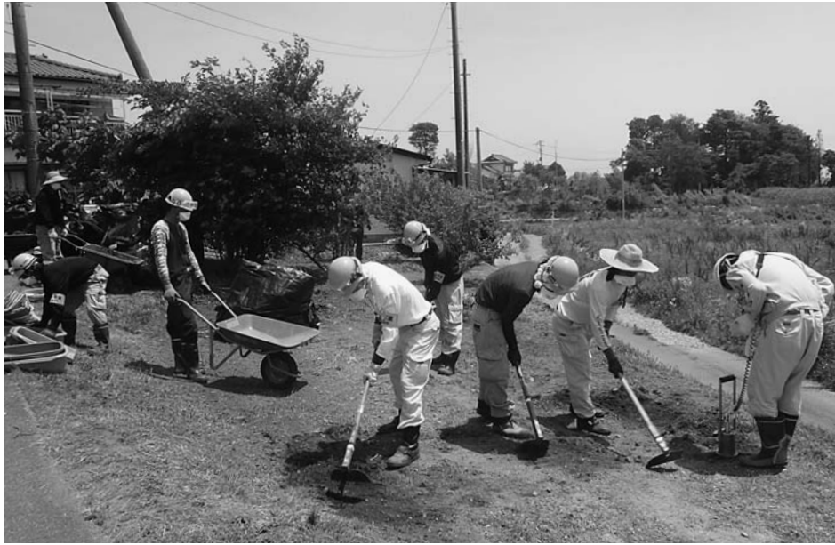
町内除染作業のようす
