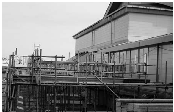
改修中の中学校実習棟
