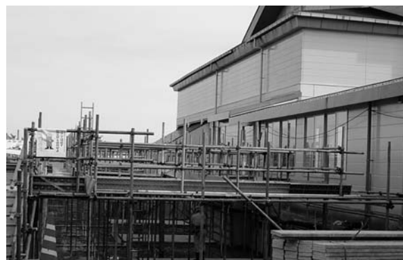
改修中の中学校実習棟
