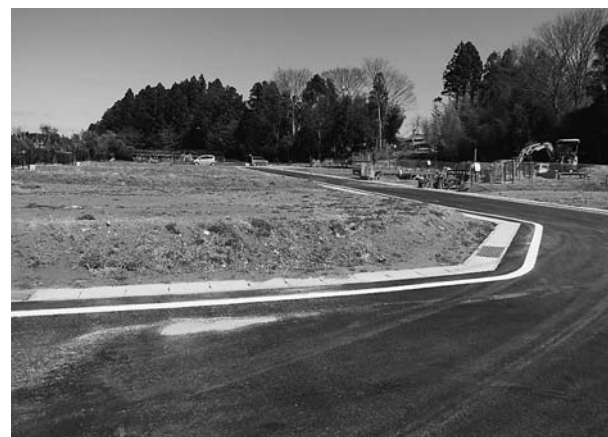
建築に取り掛かる分譲地（大吹地区）
