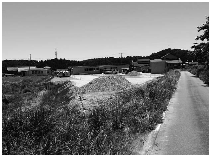
富岡土木事務所の建設が進む駅東側
