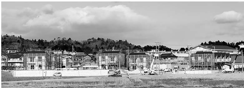
急ピッチで建設が進む災害公営住宅
