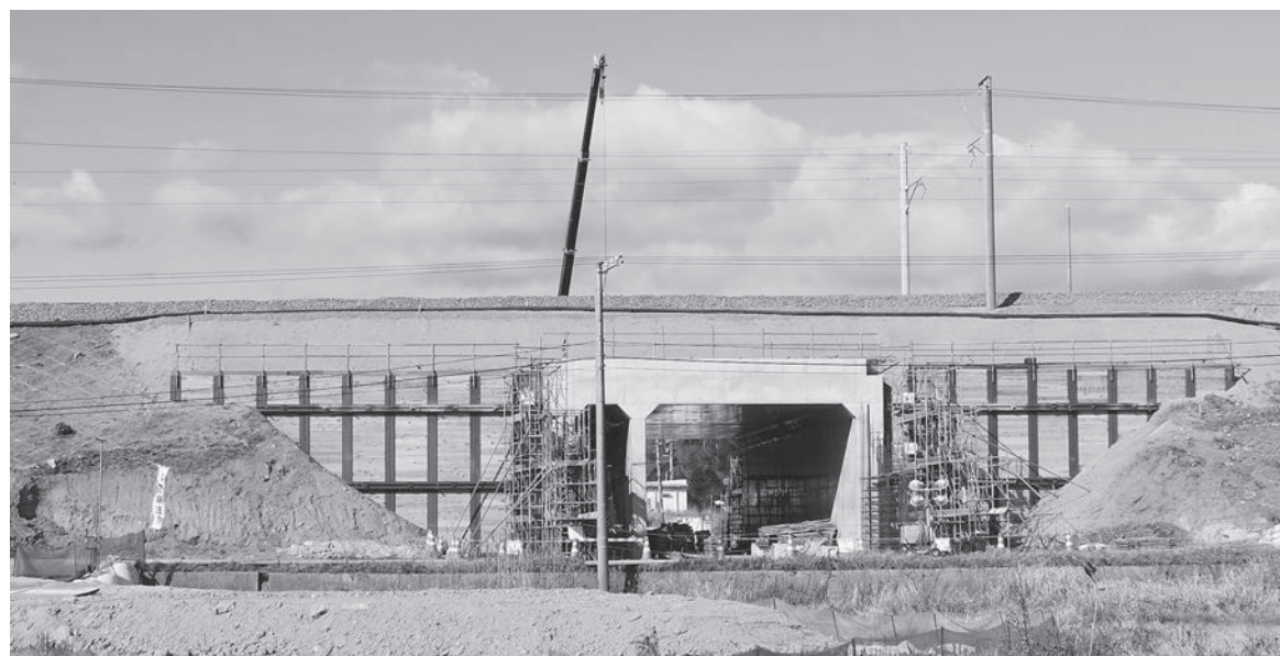
工事が進む久保田こ道橋
