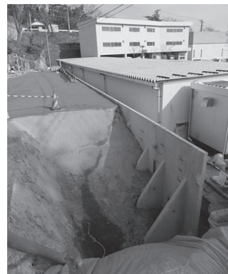
工事が行われている苗代替地区
