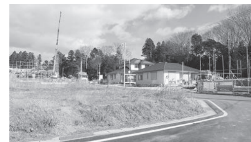
町内に建設中の住宅（大吹地区分譲地）
