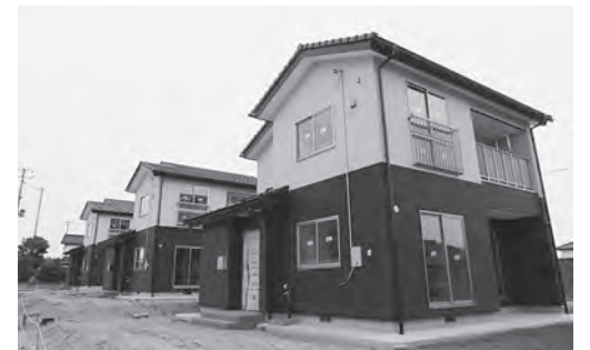
完成に近づく災害公営住宅
