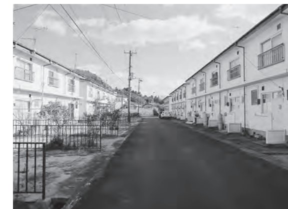
改修が予定される町営住宅
