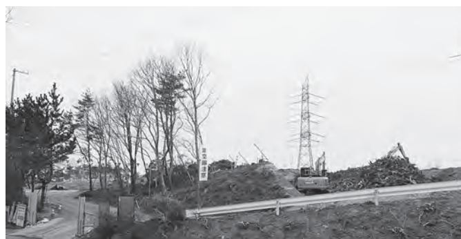
減容化施設建設の造成工事
