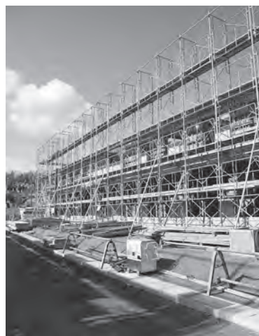
建設中の災害公営住宅
