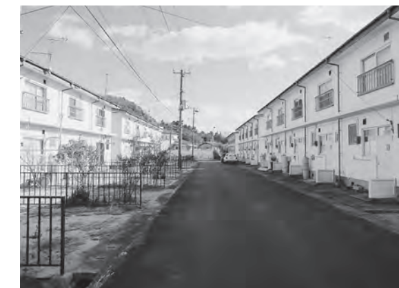
改修が予定される町営住宅
