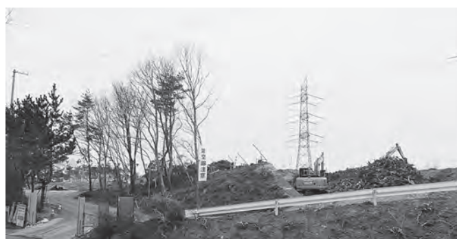
減容化施設建設の造成工事
