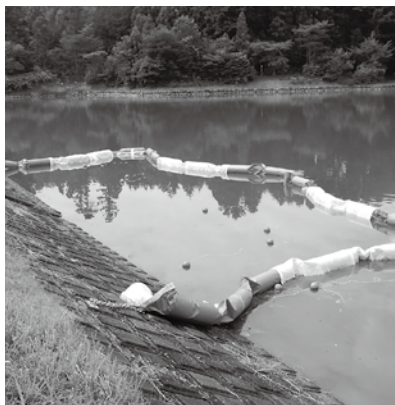
汚染拡散防止のためのシルトフェンス（西の沢ため池）
