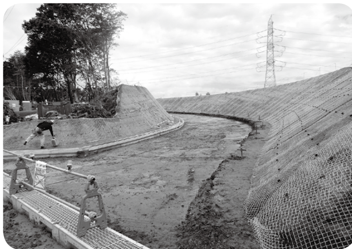
早期完成が望まれる減容化施設
