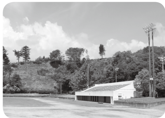
中高一貫校建設予定地では土取り工事が始まる
