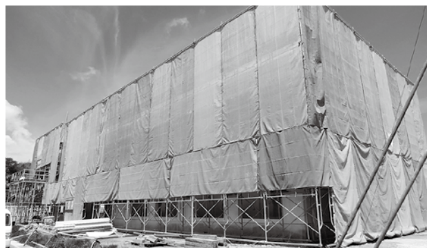
完成に向けて工事が進む1工区
