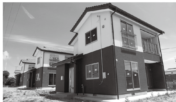
内装が終了した2工区
