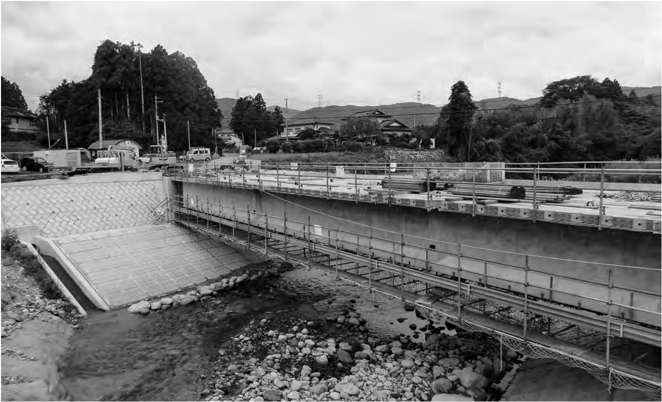
完成間近な小松橋
