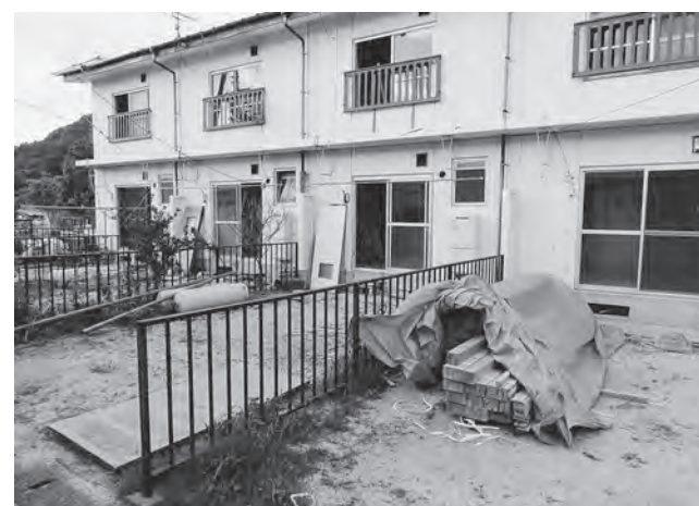
修繕される町営住宅
