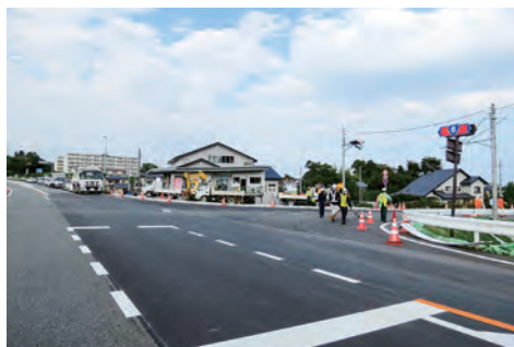
改良工事が行われている桜田交差点
