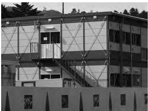
町内に多く建設される宿舎
