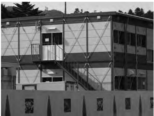
町内に多く建設される宿舎
