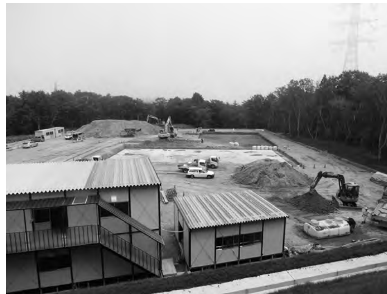
減容化施設建設に向けて整備が進む
