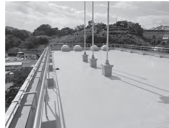
太陽光パネルが設置される庁舎屋上
