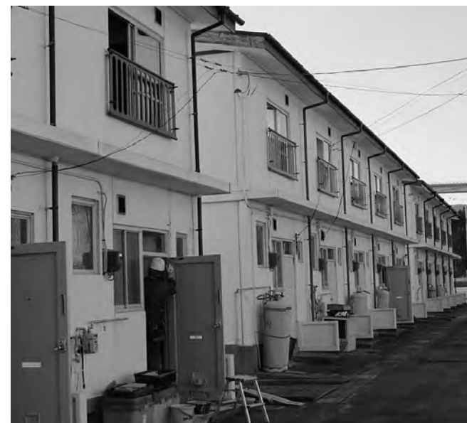
内装工事が進む町営住宅
