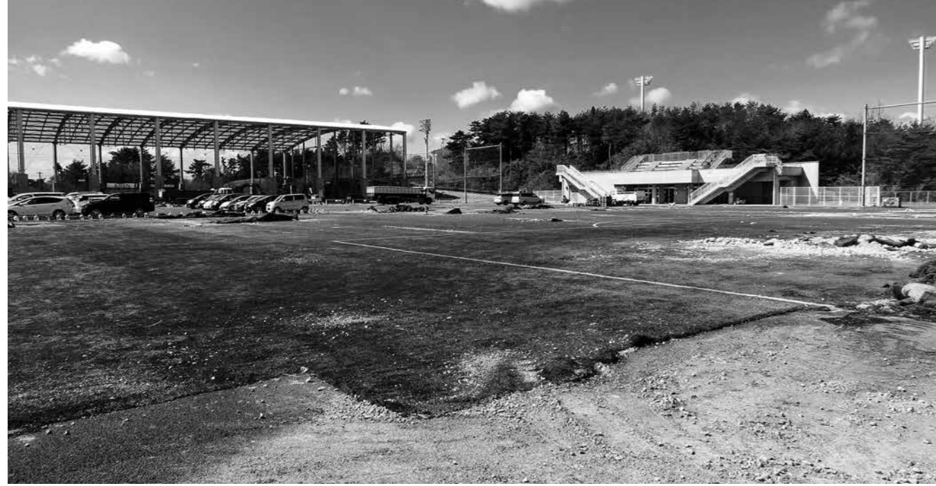
改修の準備が進む広野町サッカー場
