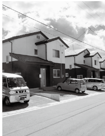
住宅整備が完了した1期工事
