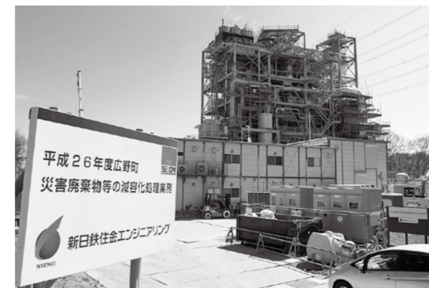
4月に稼働する仮設減容化処理施設
