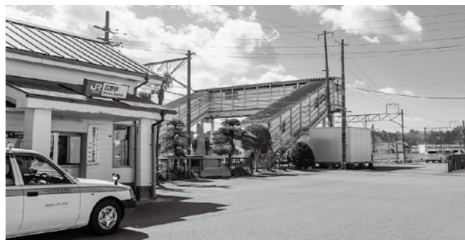
自由通路を建設予定の広野駅
