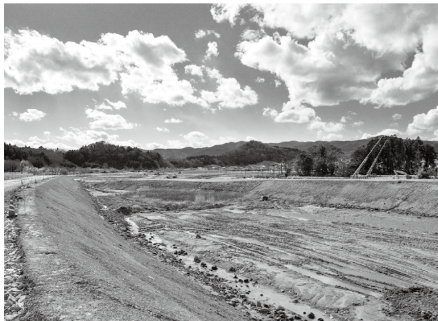
道路建設工事が進む浅見川河口付近
