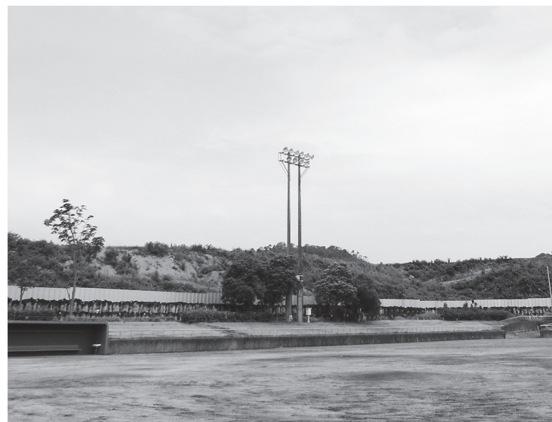
中高一貫校の造成に向け進む工事
