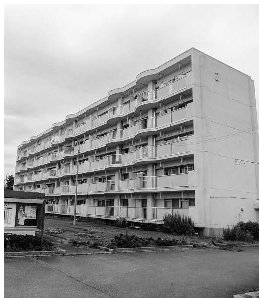
入居が進む町営住宅（桜田住宅）
