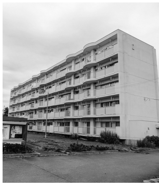
入居が進む町営住宅（桜田住宅）
