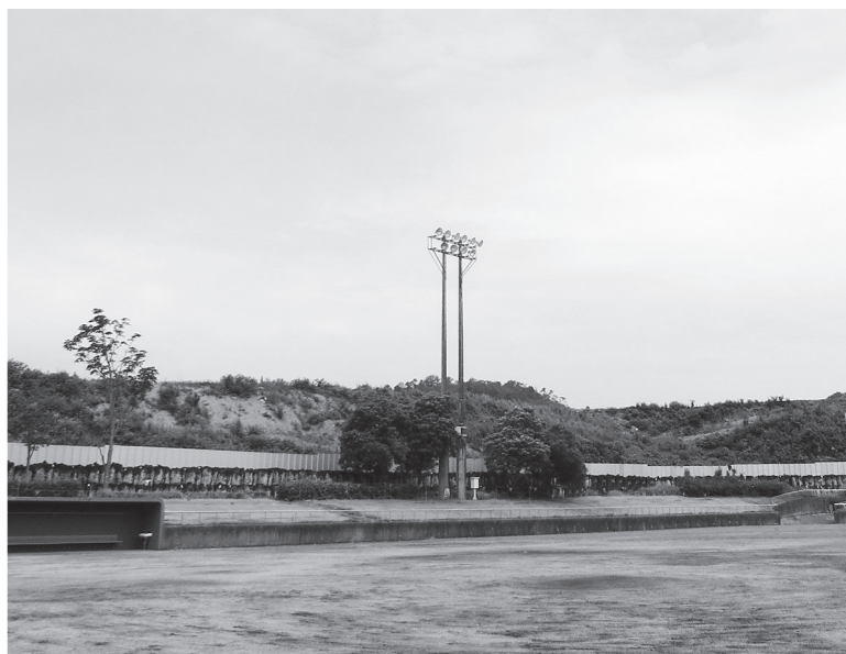
中高一貫校の造成に向け進む工事
